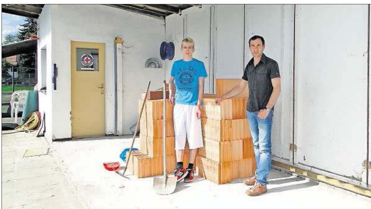
Daniel Mallon (r.), Vorsitzender des Vereins der Schwimmbadfreunde Rippershausen, steht zusammen mit Florian Wedekind mitten in einer Vereinsbaustelle. Hier, wo sich kürzlich noch die Umkleidekabinen befanden, entstehen neue Räumlichkeiten, die künftig als Lager genutzt werden sollen.
