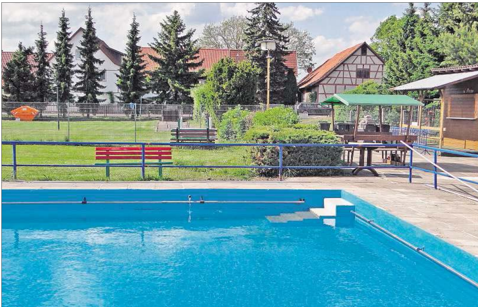
Rund 500 000 Liter Wasser fasst das Schwimmbecken in Rippershausen. Mehr als die Hälfte davon muss jetzt noch einmal abgelassen werden, damit an die neuen Eingangstreppe im Nichtschwimmerbereich noch Geländern angebracht werden können. Eine der neuen Treppen ist rechts im Bild zu sehen. Fotos: O. Benkert
